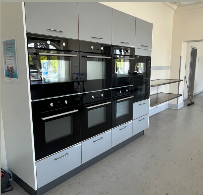
Funktionsopdelt opstilling med indbyggede ovne i arbejdsvenlig højde
