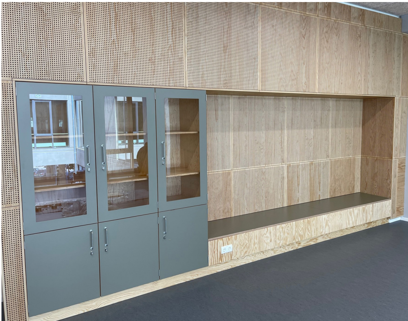
Skolen i Sydhavnen 2023. integreret læsehule og akustik bagvæg
